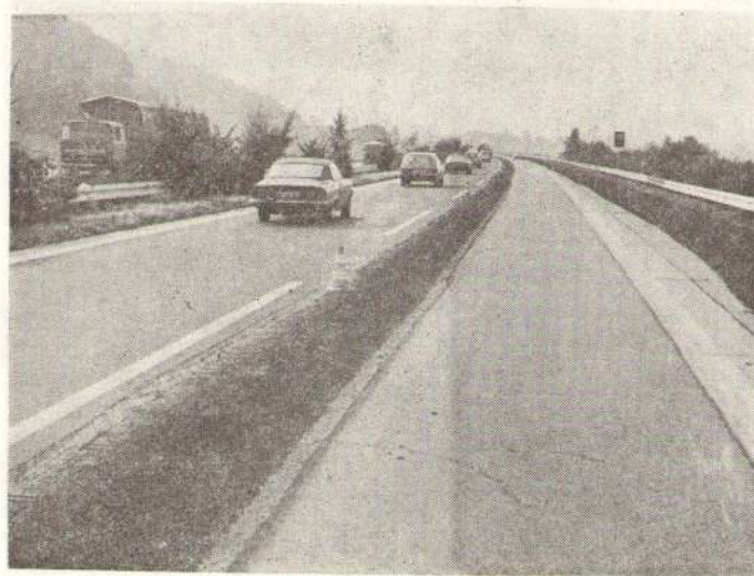
Сл. 6 — Коловоз на коме је обављена оправка колотрага
