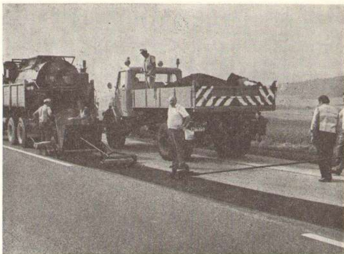
Сл. 5 — Оправка колотрага коришћењем специјалног асфалтног мастика
