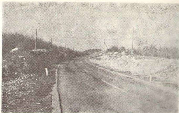
Сл. 8 — Усек на планини Тресибаби просечен методом масовног минирања
