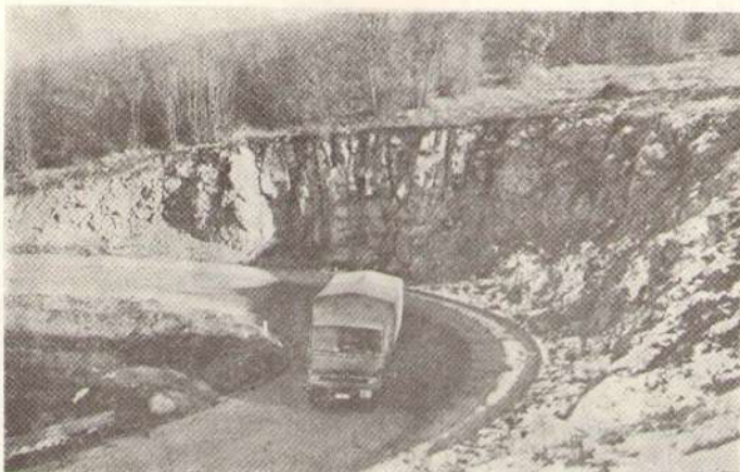
Сл. 9 — Серпентина на планини Тресибаци просечена контурним бушењем методом масовног минирања
