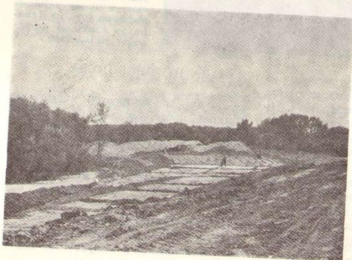
Сл. 5 — Изглед дела насипа после скидања материјала до предвиђене дубине и израда касета за воду ради квашења материјала
