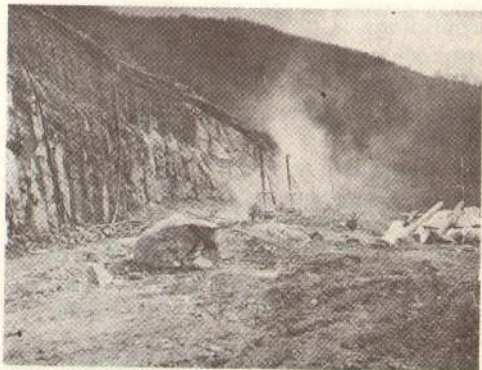
Сл. 10 — Изграда засека на 14+400 km
