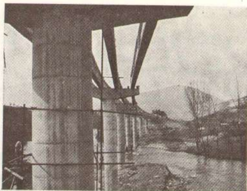
Сл. 4 — Изградња моста код Какња, на 27+741 km
