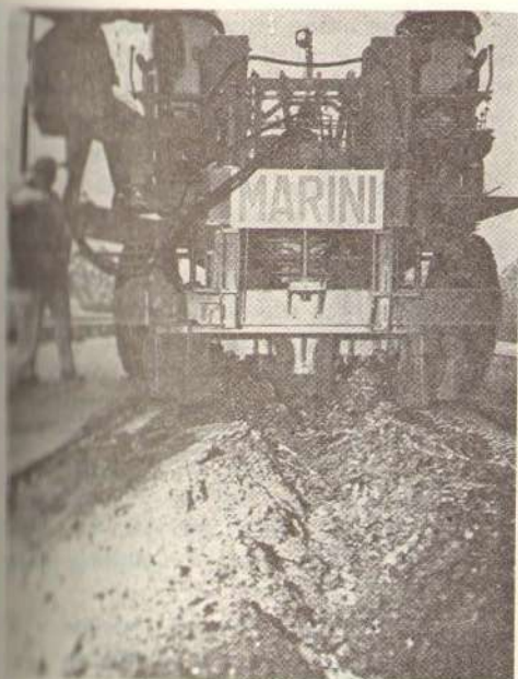
Рис. 2 — Поступак скидања претходно разгрејаног асфалтног слоја
