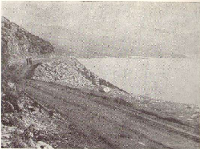
Сл. 4 — Део трасе у грађењу на 6+000 км, са погледом на изванредне плаже
