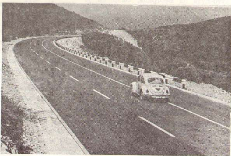
Сл. 7 — Једна деоница Јадранског пута између Бара и Улциња, са траком за спора возила
