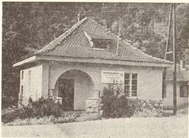
Сл. 1 — Путарска кућа Предузећа за путеве „Ниш“ у Островици уступљена Теренској лабораторији Института за путеве из Београда
