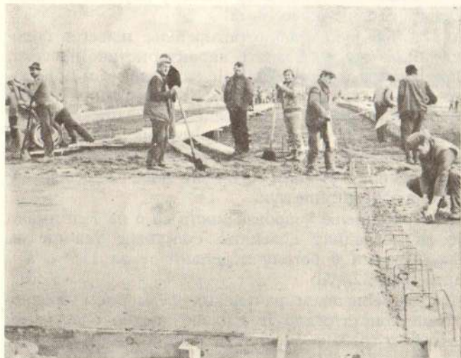
Сл. 6 — Бетонирање коловозне плоче
