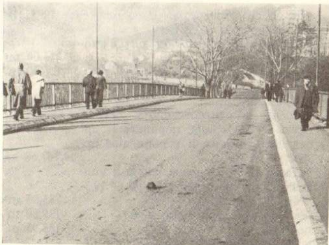
Сл. 7 — Изглед реконструисаног моста
