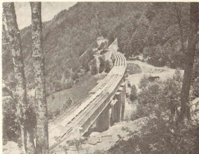
Сл. 10 — Мост од преднапрегнутог бетона преко Бијелог потока између железничких станица Колашин и Островица
