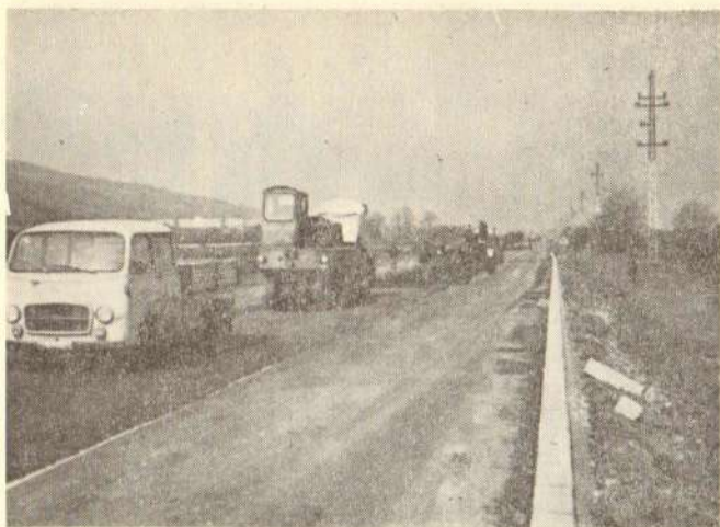
Сл. 6 — Превођење двоспратног попречног нагиба у једностранни слојем битуминизираниог агрегата на постојећем коловозу
