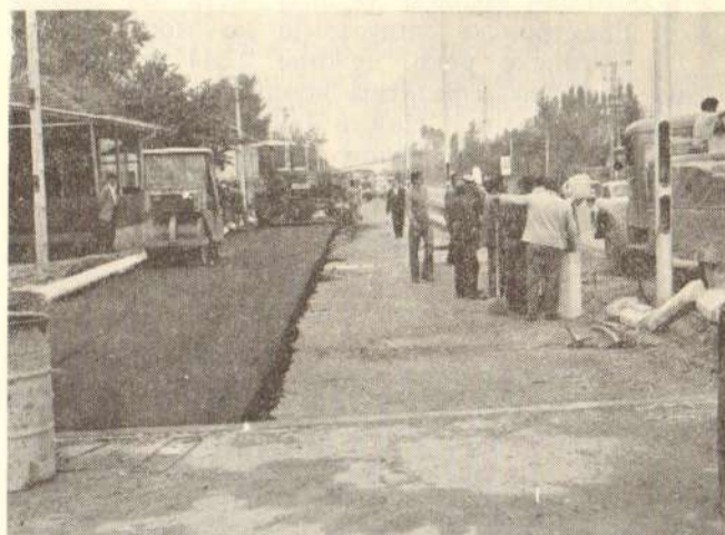
Сл. 5 — Израда издигнутих ивичњака и носећег слоја од битуменом обавијеног шљунка
