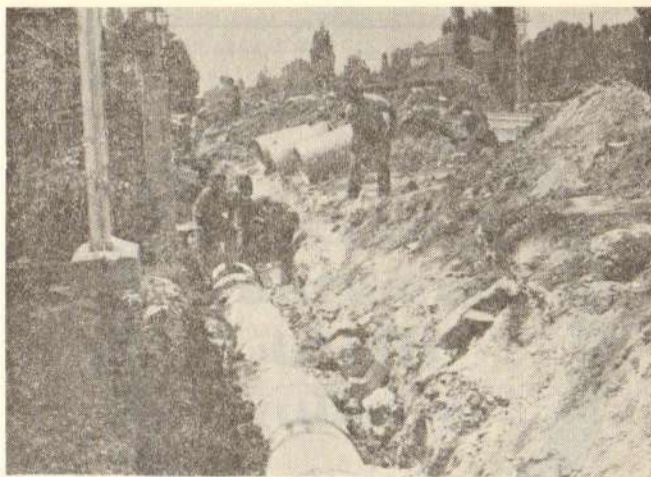
Сл. 8 — Израда кишне канализације кроз насеље „Никола Тесла“
