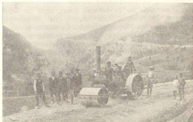
Сл. 2 — Механизација за израду тучаничког коловозног застора
