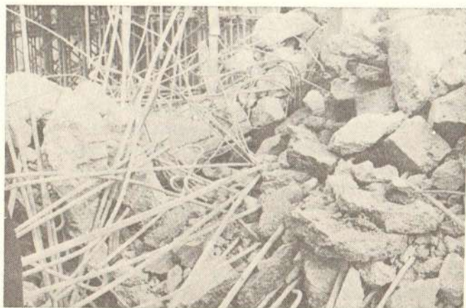
Сл. 10 — Изглед арматуре и бетонских блокова после минирања
