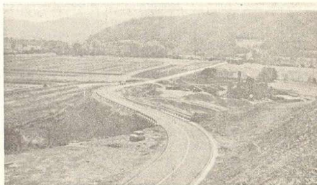
Сл. 7 — Изглед пута на 18 + 887 км са надвожњаком преко железничке пруге
