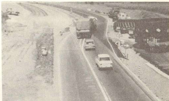
Сл. 3 — Оштра „S“ кривина на споју постојећег и новоизграђеног коловоза
