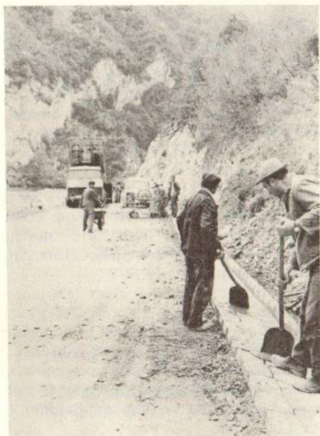
Сл. 4 — Израда монтажних ригола и носећег слоја од битуминизованог шљунка
