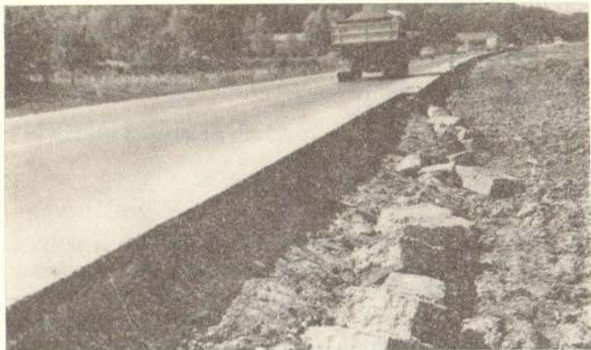
Сл. 2 — Постојећи коловоз по коме се одвија саобраћај, без ивичне траке и банке
