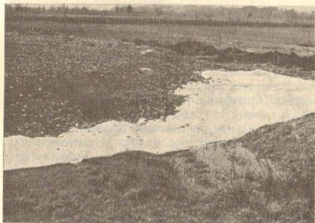
Сл. 17 — „Политлак“ постављен непосредно на природни терен испод слоја од каменог материјала који служи као привремени коловоз
