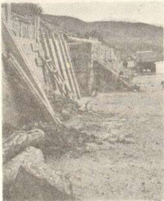
Сл. 3 — Израда новог потпорног зида на месту деформисаног на јадранском путу код Бијеле
