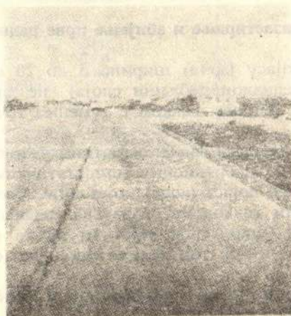
Сл. 5 — Појава подужне прслине на радном споју који се поклапа са трагом кретања точкова возила.
