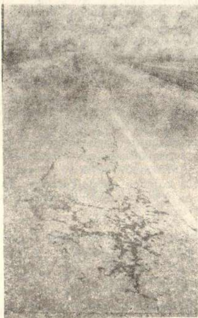
Сл. 5 — Западни пут, деоница Скопје — Тетово. Услед некавалитетне израде горњих асфалтних слојева у току зиме су се појавиле пукотине. Неконтролисано сољење у току зиме довело је до превелике концентрације соли ( \text{NaCl}_2 ) у тим пукотинама и због тога се повећава време задржавања воде. Нагли пад температуре негативно би утицао на коловоз.
