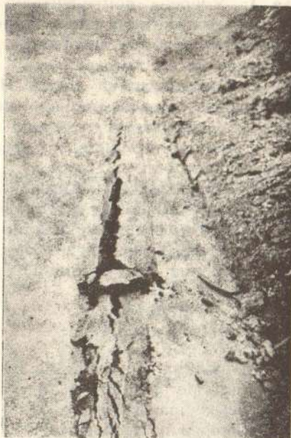
Сл. 6 — Западни пут, деоница Скопје — Тетово. Непрописне косине усека у распаднутим шкриљцима након обилних киша помериле се тако да су оштетиле риголу и део коловоза. Пример заједничког дејства, геолошко-геомеханичког и климатско-хидролошког чиниоца.
