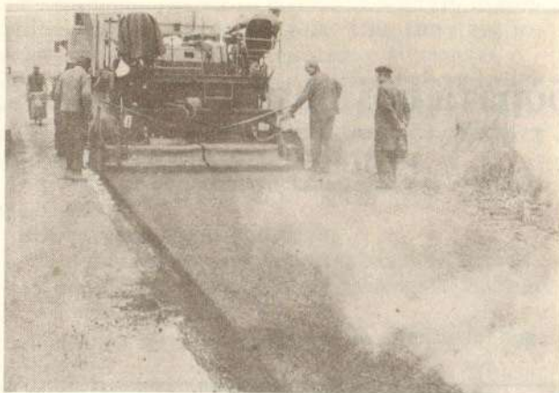
Сл. 11 — Израда асфалтне појачања коловозне конструкције једне саобраћајнице у Винковцима уз примену полиестерских мрежа
