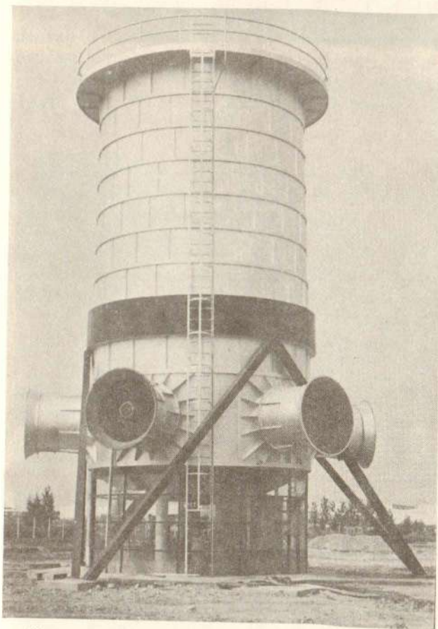
Торањ за хлађење воде фабрике „27. март“ — Н. Сад
