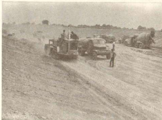
Сл. 1 — Припрема цементном стабилизационој мешавини на месту уградње уређајем Bros
