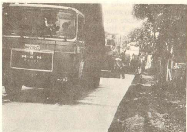
Сл. 10 — Примена полиестерских мрежа приликом израде асфалтног појачања коловозне конструкције у Борову
