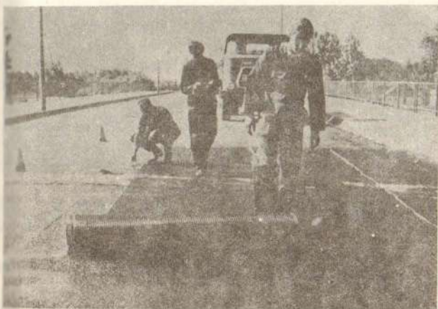
Сл. 3 — Полагање полиестерске мреже на делу дилатације бетонског моста
