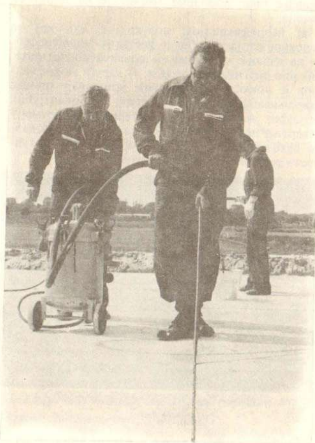
Сл. 7 — Опрема за испуну спојница масом под притиском
