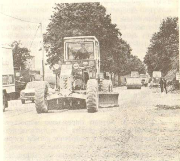
Сл. 3 — Појачавање коловозне конструкције слојем шљунка са великом количином гранулиране згуре; радови се изводе без прекида саобраћаја.
