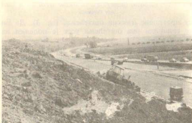
Сл. 4 — Хумусирање косине великог усека и припремање сипарот и новог ауто-пута
