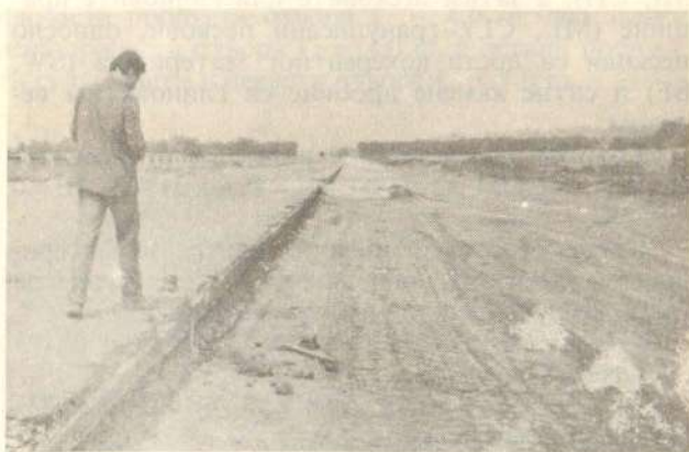
Сл. 5 — Проширење левог коловоза за 2,8 m и контрола збијености
