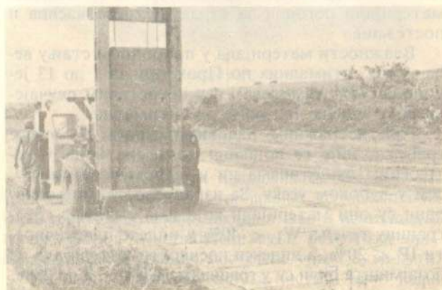
Сл. 6 — Разбијање цементно-бетонског коловоза машином Wirtgen
