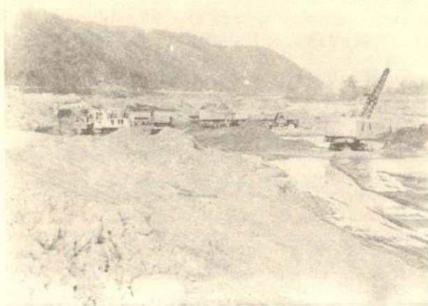
Сл. 6 — Ископ шљунковитог материјала из кинеске просека новог корита коришћеног за израду шрупа ауто-пута кроз воду
