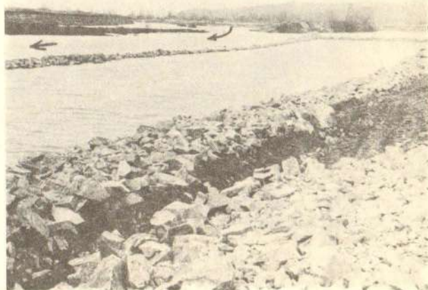
Сл. 9 — Камени облога пожење насипа ауто-пута и регулисаног корита Велике Мораве означено стрелицама
