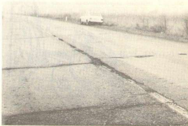
Сл. 9. Изглед цементно-бетонској коловоза после разбијања
