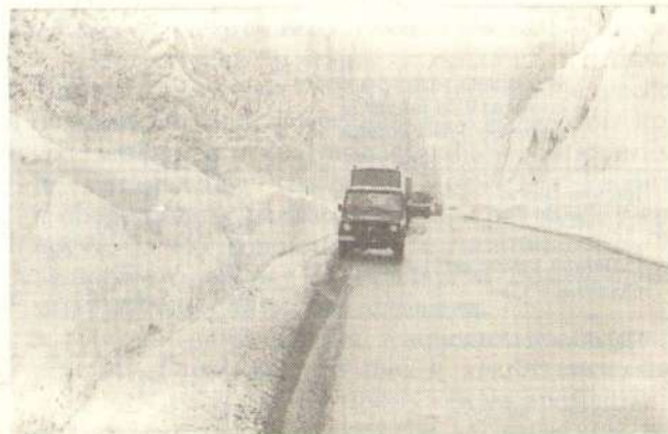
Сл. 3 — Изглед очишћеног коловоза „на црно“ посућеном сољу против поледице
