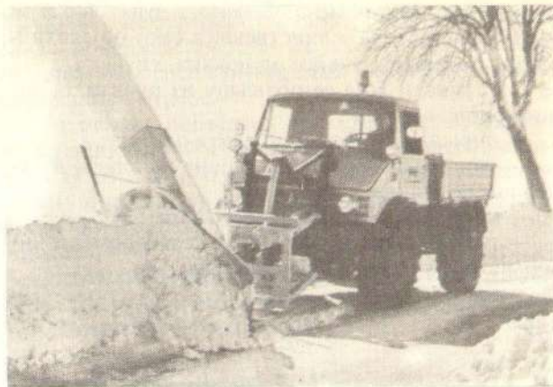
Сл. 3 — Возило ФАП са дозирачем соли П—80 и једносигурним вентилом за снег на предњем делу возила
