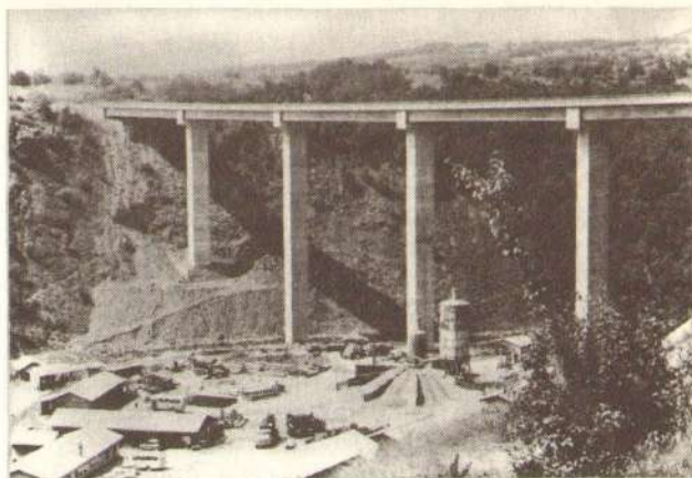
Сл. 8 — Изглед моста са градилиштем
