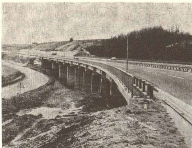
Сл. 4 — Изглед вијадукта на km\ 765+750
