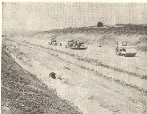
Сл. 7 — Изградња тампонског слоја на km\ 771+200
