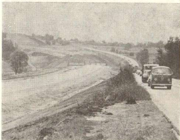
Сл. 1 — Изградња доњег строја на km 772+000 поред постојећег пута
