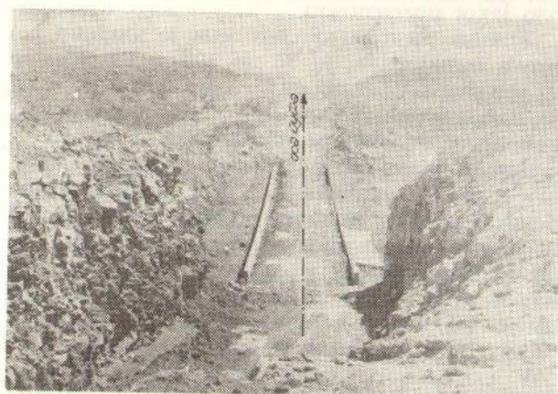
Сл. 7 — Радијер са завршним зидовима и преливном плочом (размер 1:100)
