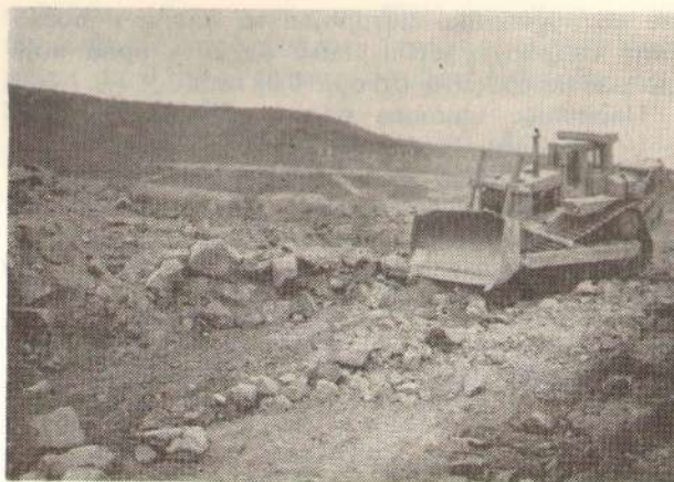
Сл. 3 — Рад булдожера CAT D9L на ископу усека
