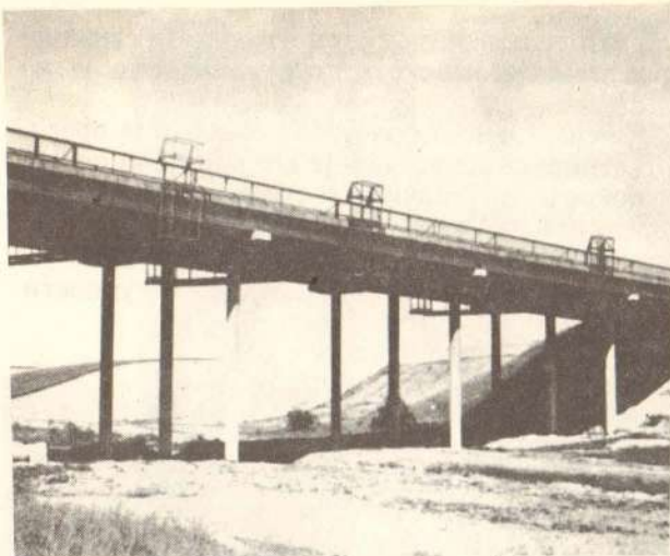
Сл. 6. Мост „Патка вода” - изглед у току санације
