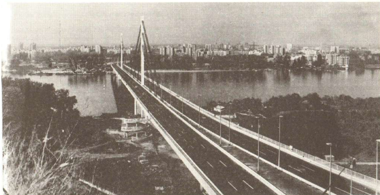
Слика 1 – Изглед друмског моста Слободе
