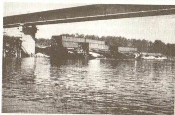
Слика 8 – Предмонтирани елементи на монтажној платформи
