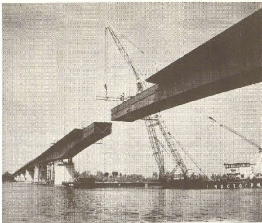
Слика 3 – Монтажа поља челичне конструкције пловном дизалицом "Миљацка"
