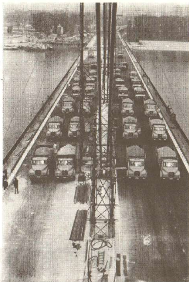
Слика 6 – Пробно оптерећење моста
