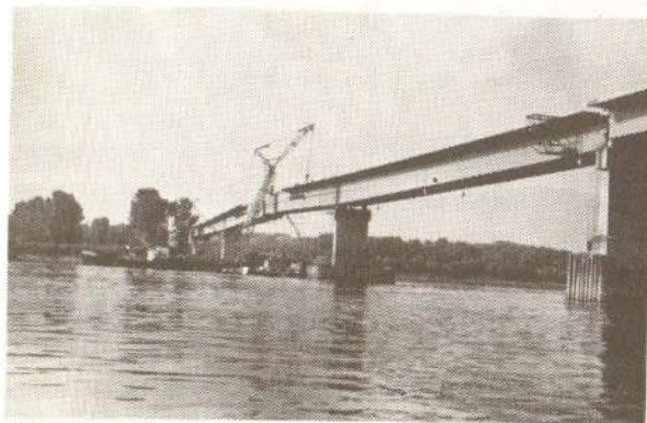
Слика 6 – Монтажа конструкције отвора 8–9
