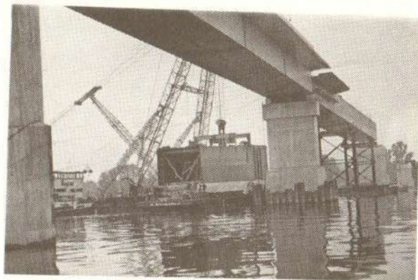
Слика 7 – Монтажа петог елемента отвора бр. 7–8. На стубу бр. 7 види се изведено ојачање стуба.
