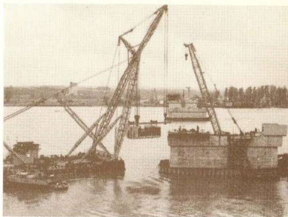
Монтажа челичне конструкције моста преко Саве на обилазници ауто пута око Београда, главни отвор распона L=198,0 м.
