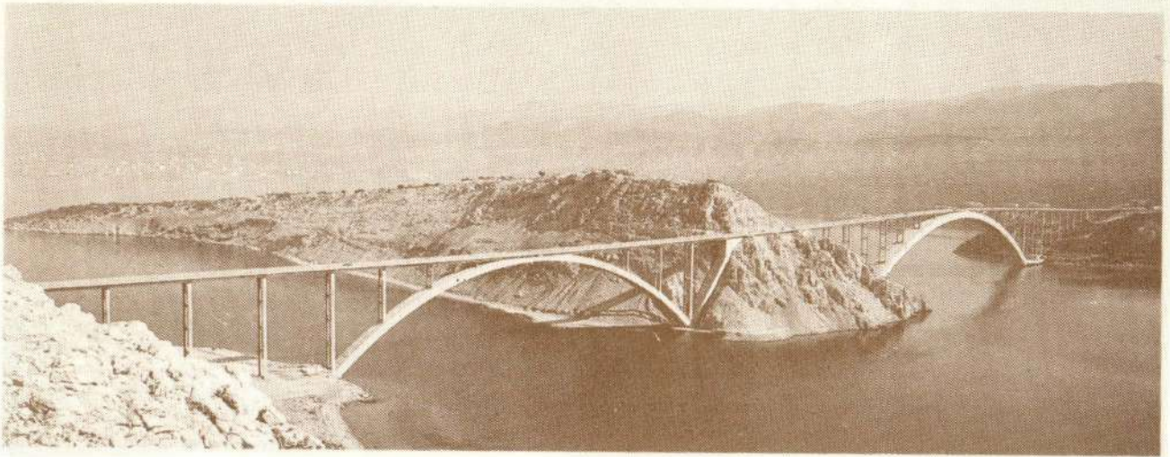
Друмски мост L=1.309,50 м од преднапрегнутог бетона "Копно – Св. Марко – острво Крк", са два бетонска лука, велики лук распона 390,0 м, и мањи распона 244,0 м.
