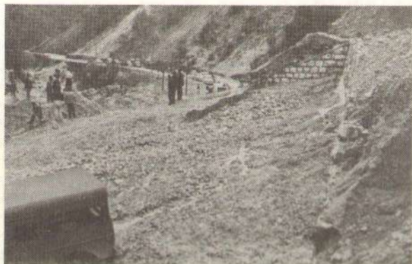
Слика 3 – Прекид саобраћаја због наноса материјала од 10.000м 3 , на осмом километру од Пећи ка Чакору (29.07.1967. године)
