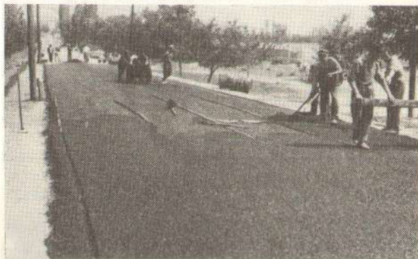
Слика 4 – Уграђивање асфалта справљеног по хладном поступку 1965. године
