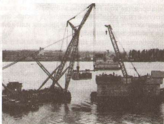
Монтажа челичне конструкције моста преко Саве на обилазници ауто пута око Београда, главни отвор распона L = 198,0 м.
