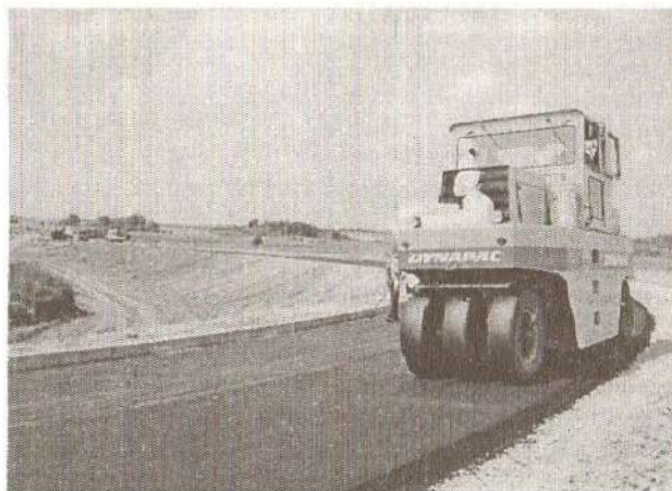
Слика 4. Израда слоја асфалтбетона АБ11с на крају петље "Фекетић (извођач радова ДД "Бачкапут", Нови Сад)
