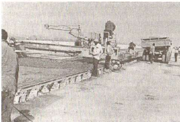
Слика 4. Извођење цемент бетонског коловоза
