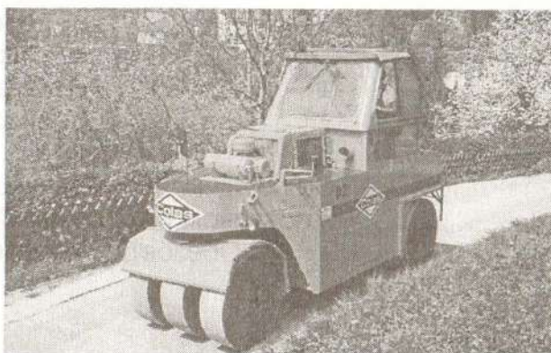
VALJAK SA PNEUMATSKIM TOČKOVIMA za utiskivanje agregata u emulziju
