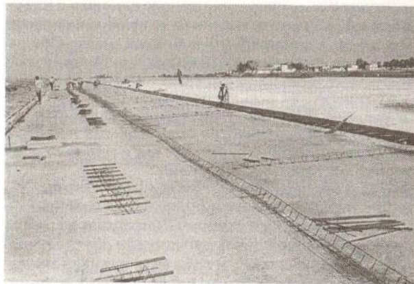
Слика 3. Извођење цемент бетонског коловоза
