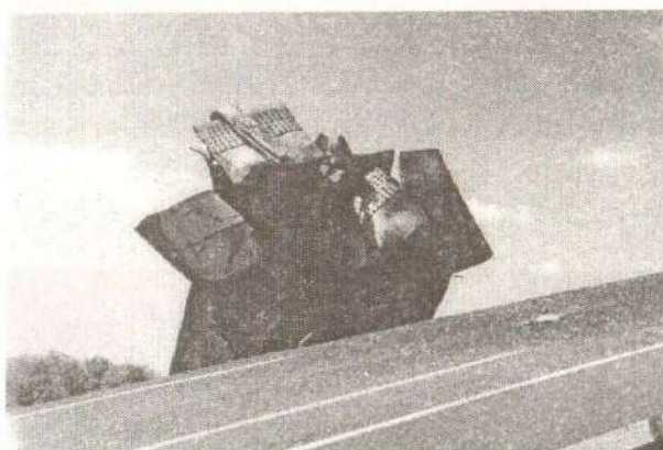
Слика 12. Изглед срушеног пилона
