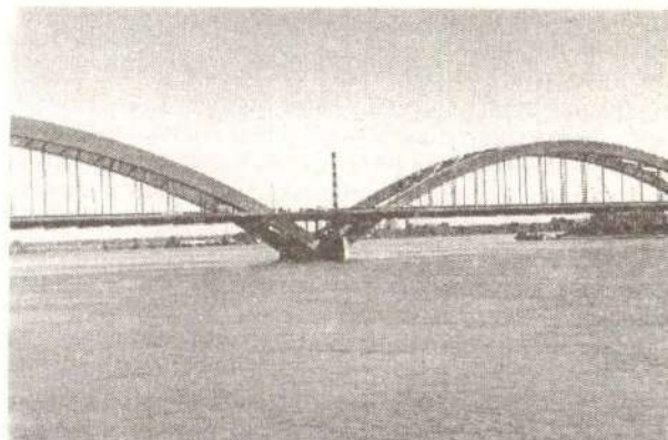
Слика 21. Радови на санацији оштећене конструкције на делу речног стуба
