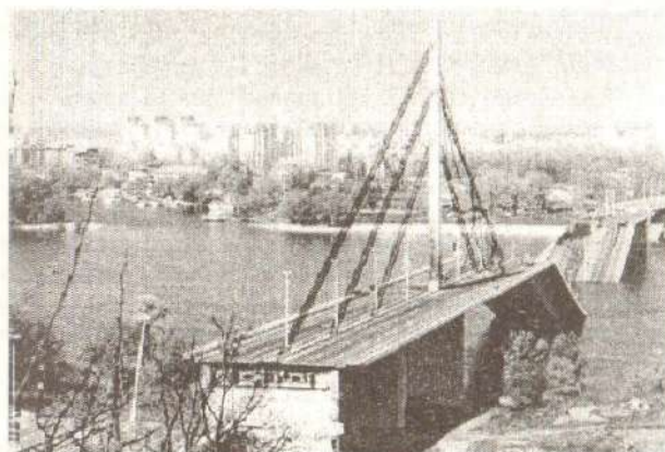
Слика 8. Срушена конструкција моста са десне (каменичке) стране (срушено поље прилазне конструкције, оштећен пилон и покидани каблови, срушено главно поље моста)
