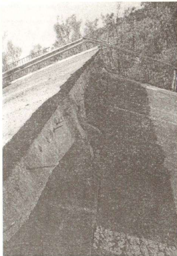
Слика 31. Детаљ прелома коловозне плоче на споју
