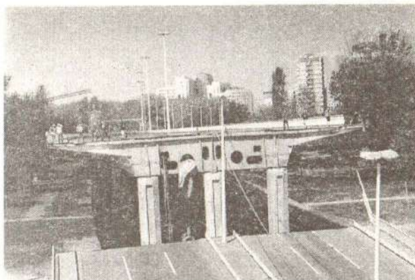
Слика 10. Рушење последњег поља прилазне конструкције са леве стране
