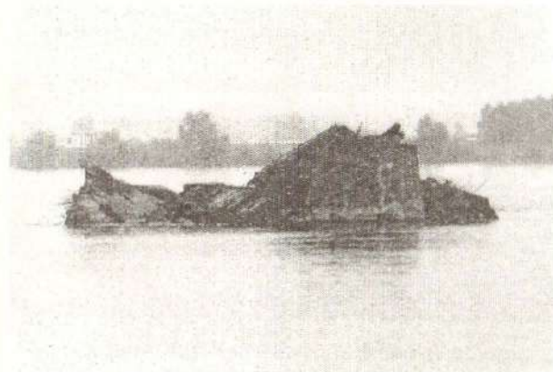
Слика 22. Рушевине речног средњег стуба Жељезног моста
