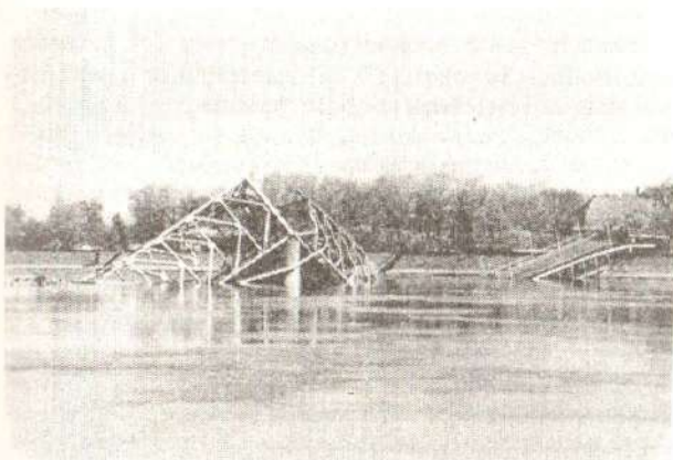
Слика 24. Рушевине Варадинског моста на месту речног стуба на петроварадинској страни
