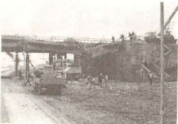
Слика 19. Радови на подупирању и санацији оштећеног дела конструкције моста
