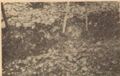
Сл. 5: Ископана подлога од шљунковитог песка обрађеног цементним малтером
