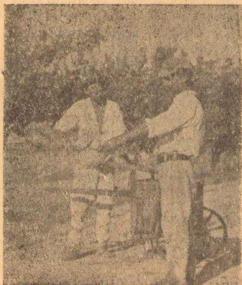
Квашење ручним пумпама места где се коловоз после ваљања разбио
