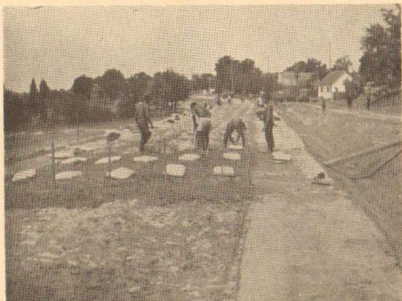
Сл. 7 Наношење и разасирање цемента
