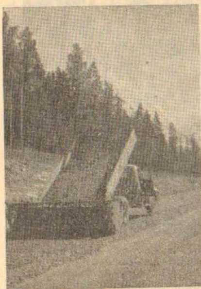
Сл. 16. Машина типа „Аман“ за разстирање каменог материјала крупноће 1—3 см.
