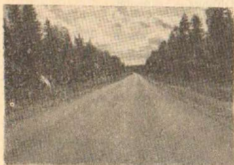
Сл. 22. Изглед новог јелнослојног асфалтног застора дебљине 5 см.
