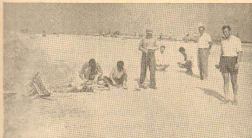
Сл. 5. Вађење непоремењених узорака из постељице
