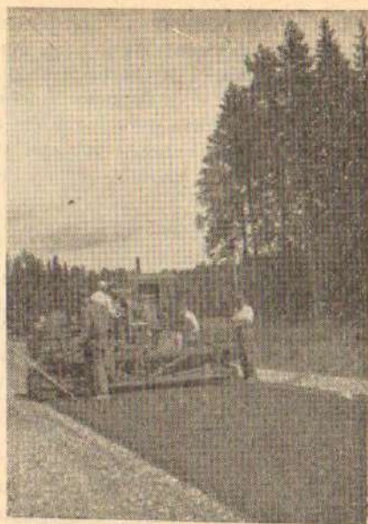
Сл. 21. Разстирач за асфалтну масу марке „Burben Green Olding—London“ у раду
