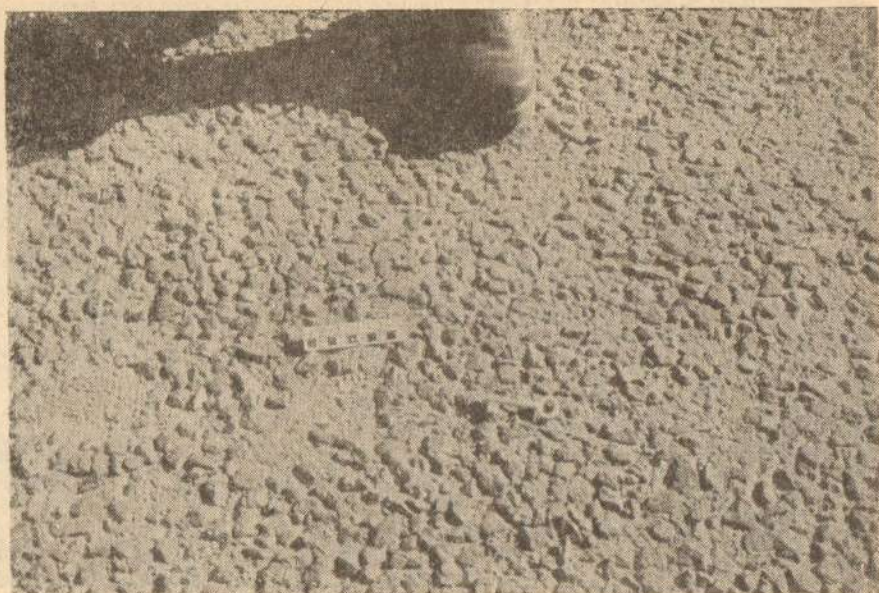
Тип I. Виде се ћелава места где је, због слабог квалитета, агрегат здробљен. Зрна прекрупна
