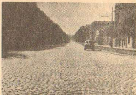
Сл. 1. Калдрме од ситне коцке заливане песком
