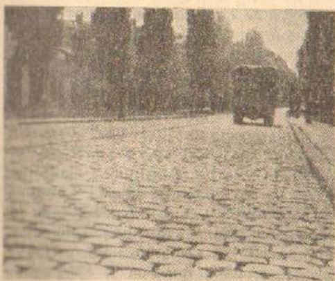
Сл. 2. Калдрме од крупне коцке заливане песком
