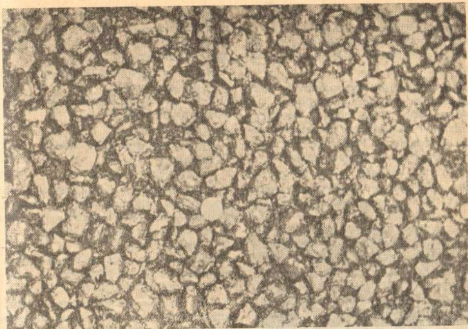
Сл. 10 Структура доњег слоја храпавог катранског бетона на путу Бистарац—Лукавац (коксара)
