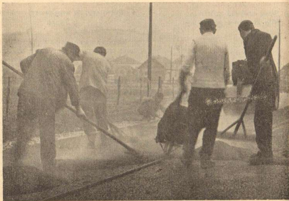
Сл. 9 Израда хабајућег слоја финог катранског бетона на путу Бистарац—Лукавац (коксара)
