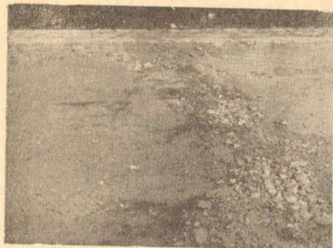
Сл. 29 Деформисање подлоге стабилизационе цементом
