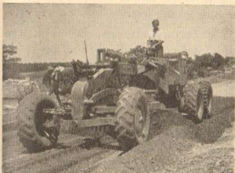
Сл. 23 Разасирање шљунка грејдером за израду механичке стабилизације
