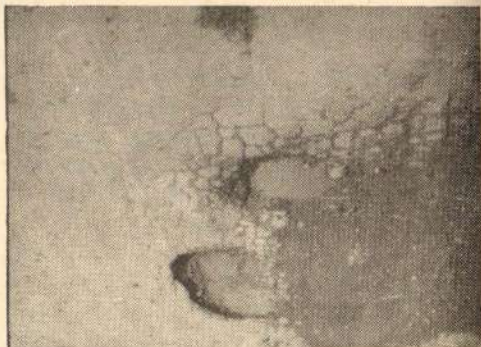
Сл. 61 Ударне рупе на асфалт тепиху III опитна деоница „Петлово брдо“
