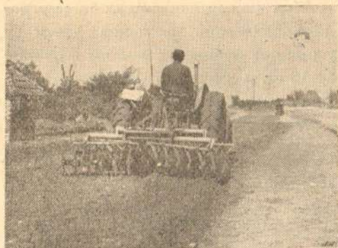
Сл. 25 Мешање шљунка и земље пољо- привредном тањирачом
