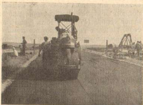
Сл. 38 Ваљање асфалт тепиха на механичкој стабилизацији
