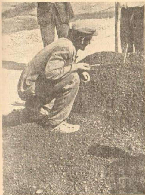
Сл. 19 Контрола температура асфалтне мешавине
