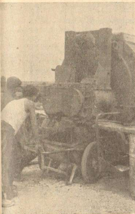
Сл. 40 Прање асфалтне масе вршен је јапанерима
