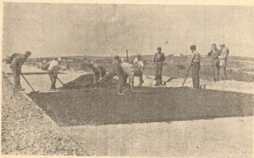
Сл. 18 Разастирање масе код израде стабилизације са разређеним битуменом
