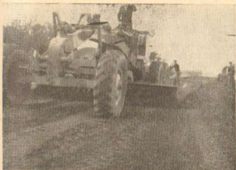
Сл. 28 Планирање стабилизације грејдером по завршеном мешању
