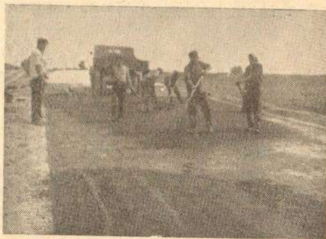
Сл. 37 Разастирање битуминизираних ситнежи као изравнавајући слој на механичкој стабилизацији
