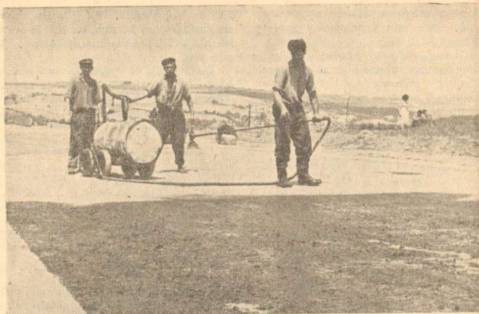
Сл. 36 Прскање механичке стабилизације нестабилном емулзијом ручном шприц машином
