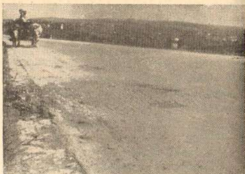
Сл. 59 Оштећења на коловозном застору на III опитној деоници „Петлово брдо“
