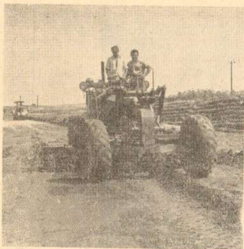
Сл. 4 Планирање и профилисање постелеице грејдером
