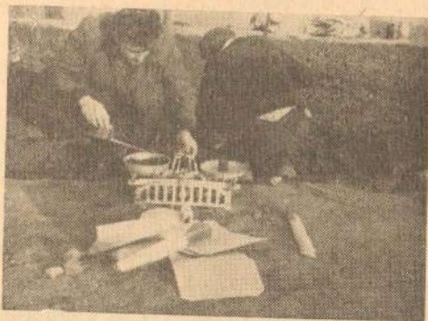
Сл. 8. Одређивање влажности при изради стабилизације кречом.
