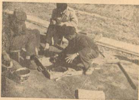
Сл. 7. Контрола запреминских тежина калибрираним песком на механичкој стабилизацији.
