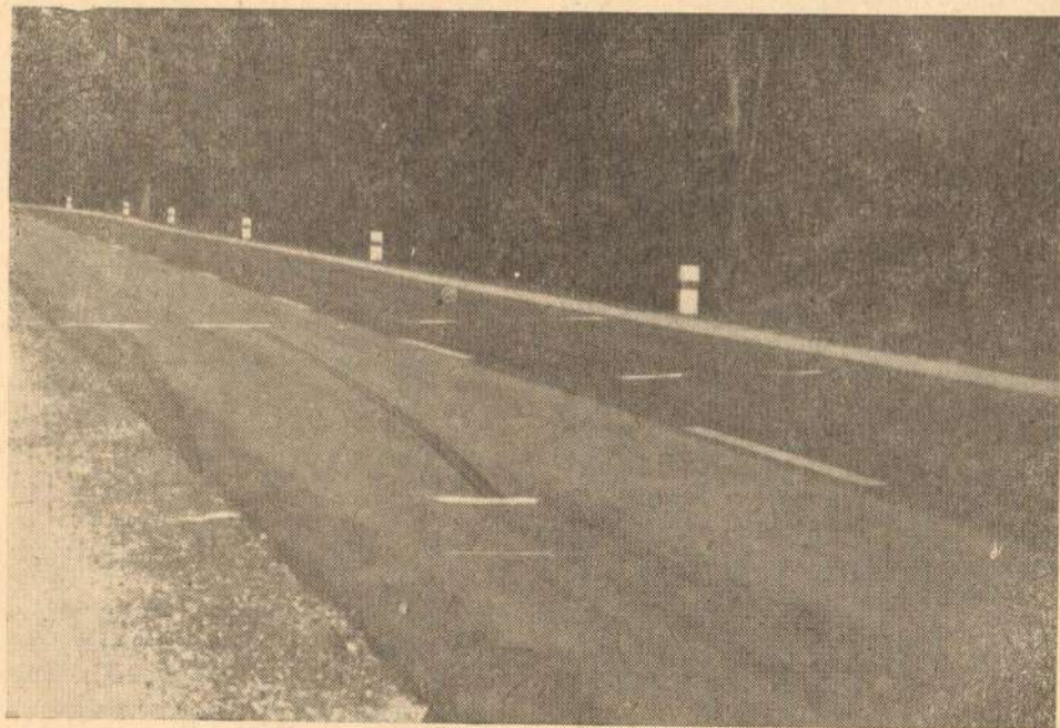
Сл. 16. На путу Сарајево—Олово аутор је испитивао трајавост катранског коловоза (тамна половина) и коловоза од разређеног битумена. Попречним белим цртама су омеђене зауставне дужине кочења „Фиата 1400“ на сухом коловозу при брзини 40 км/час.
