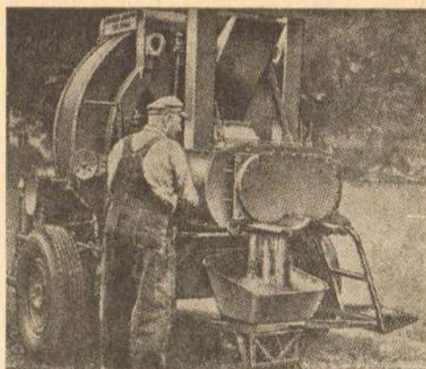
Сл. 17. Покретна мешалица за израду коловоза са угљоводоничним везивима по топлом поступку „Barber-Green-Olding” капацитета око 5 тона/час.
