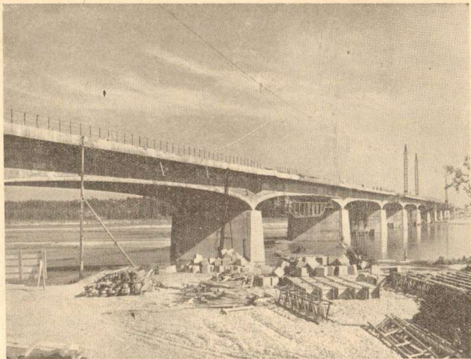
Грађење моста на реци По
