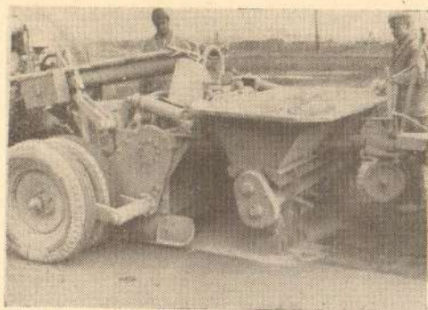
Сл. 3. Стабилизатор Ховард-183 у раду — аутоматско дозирање и разастирање цемента
