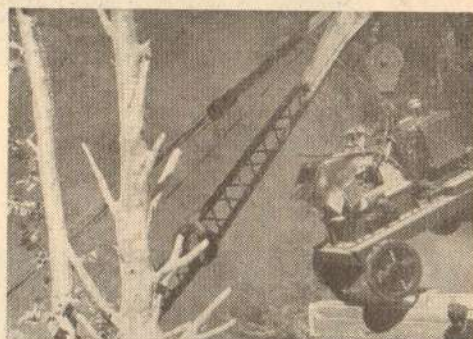
Сл. 8: Ударна — ротациона чекићара при монтажи
