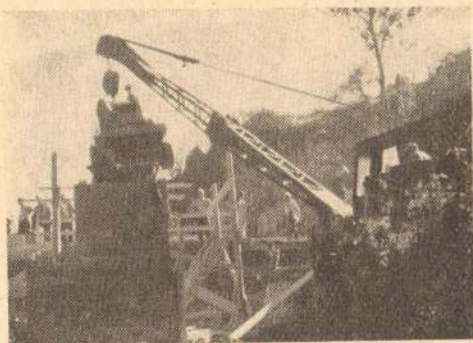
Сл. 9: Монтирање ударне чекићаре на постоље помоћу крана
