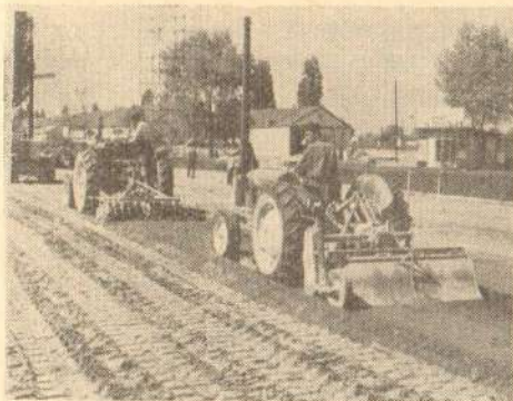
Сл. 11. Тањирача и ротоватор у радном поретку на стабилизација плато-а (лака подлога) кречом
