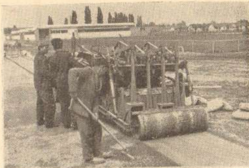
Сл. 7. Компактор Ховард-122 у раду — у даљем плану је стабилизатор који предходи раду компактора
