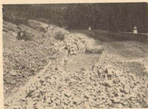
Сл. 11: Замена подлоге где је постојећа коловозна конструкција слаба
