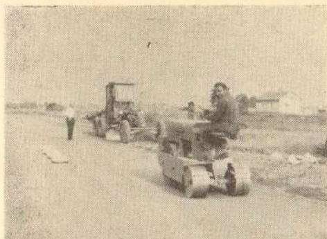
Сл. 8. Рад грејдера на уређењу траке за стабилизацију и завршно ваљање пеглање извршене стабилизације лаком виброваљком
