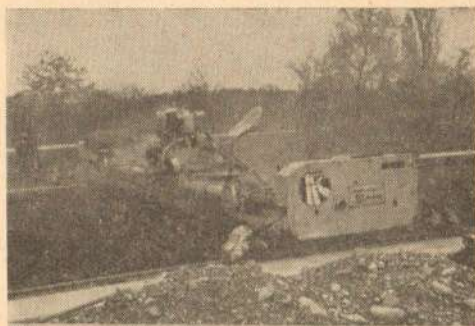
Сл. 20. Финишер за асфалт за ширину 7,50 м.
