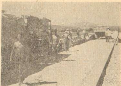
Сл. 25. Израда коловоза од цементног бетона на деоници Љубљана—Загреб.
