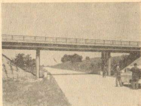
Сл. 27. Цементно бетонски коловоз на деоници Параћин—Ниш и надвозњак.
