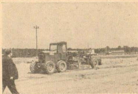
Сл. 8. Грејдер на планирању тампона.
