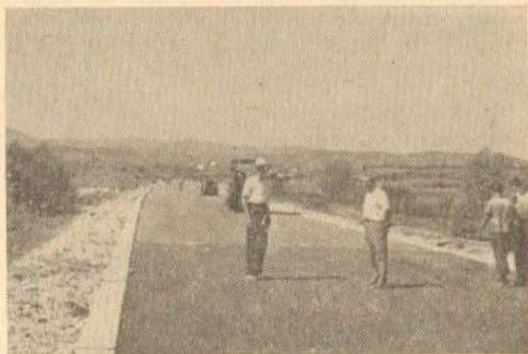
Сл. 21. Ваљање асфалтног бетона.
