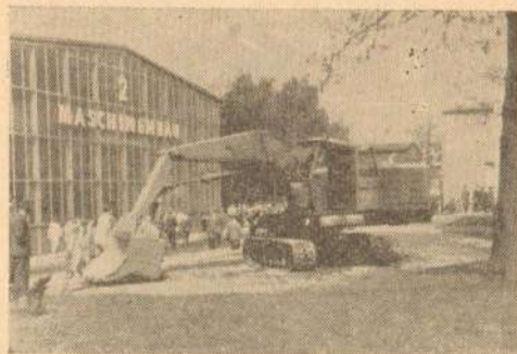
Сл. 2. Багер са хидрауличним механизмом.
