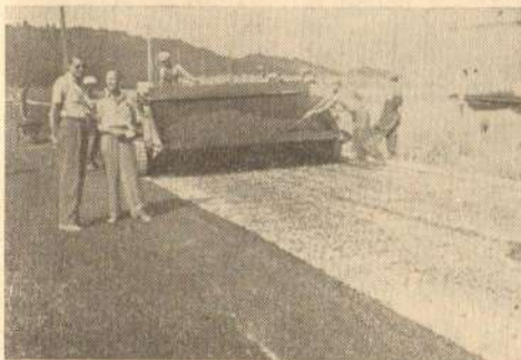
Сл. 19. Разасираще асфалтне масе финишером Бродоградилница „Тито“ на деоници аутопута Љубљана—Загреб.
