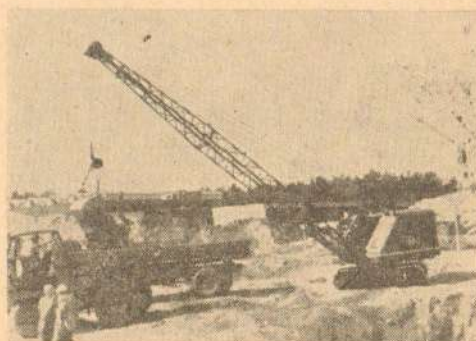
Сл. 3. Багер са механизмом са кабловима.
