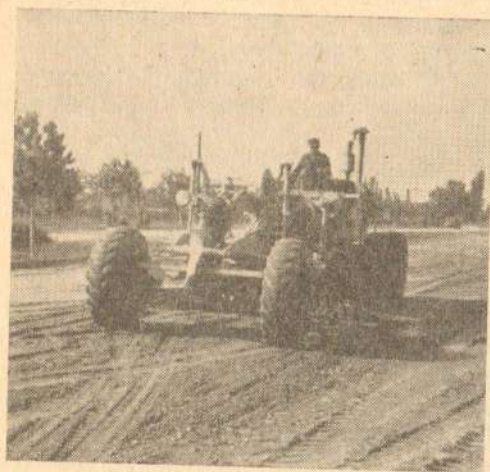
Сл. 3. Грејдер при планирању земље.
