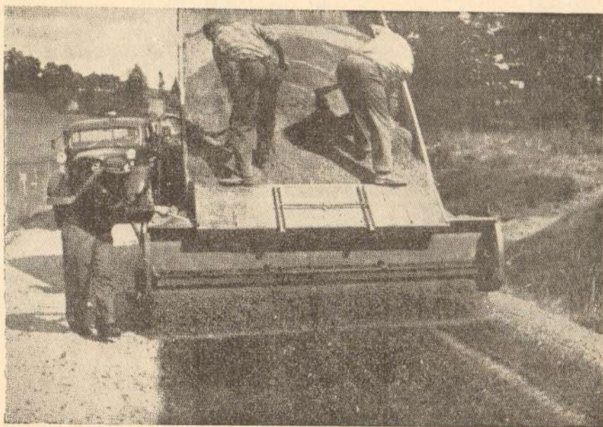
Сл. 2 — Двоструко поуљивање — Разастирање шљунка
