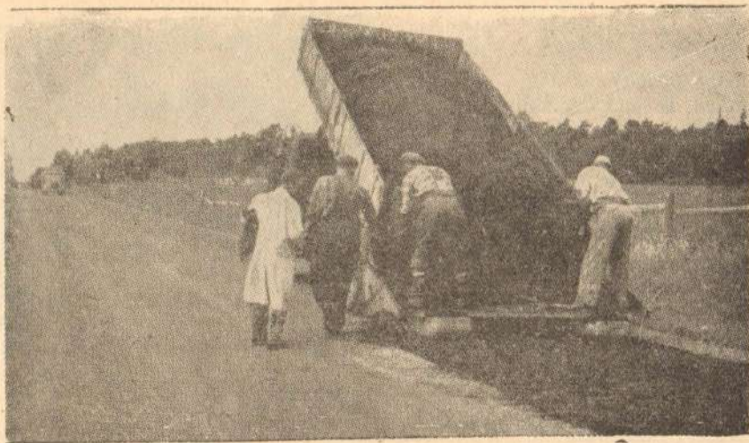
Сл. 4 — Претходно мешање — Постављање доњег слоја поуљеног шљунка.
