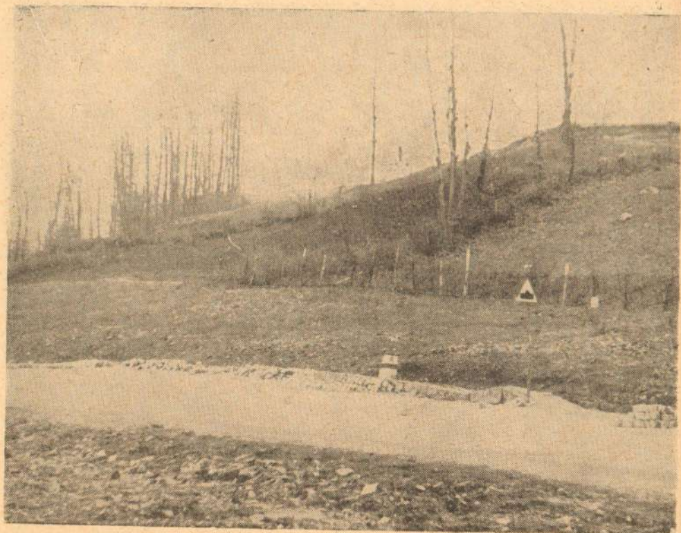
Сл. 3 изглед падине са деформисаним делом пута у селу Заграђу на 106. км
