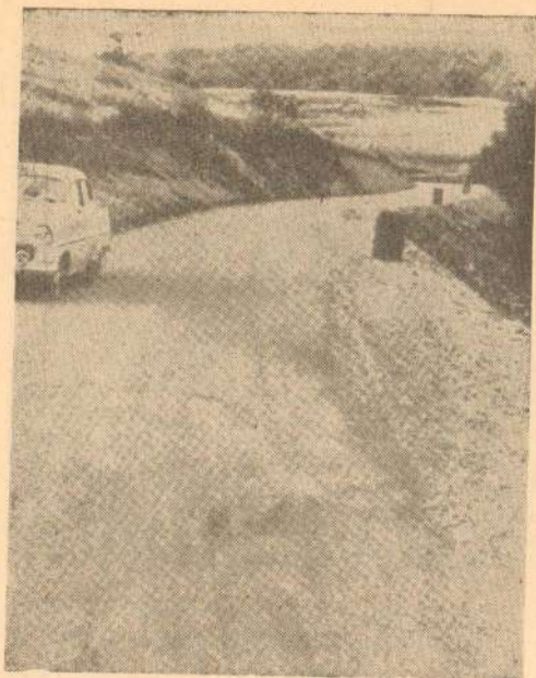
Слика 3 — Изглед једног пољског пута са подлогом стабилизovanом кречом и површинском обрадом.
