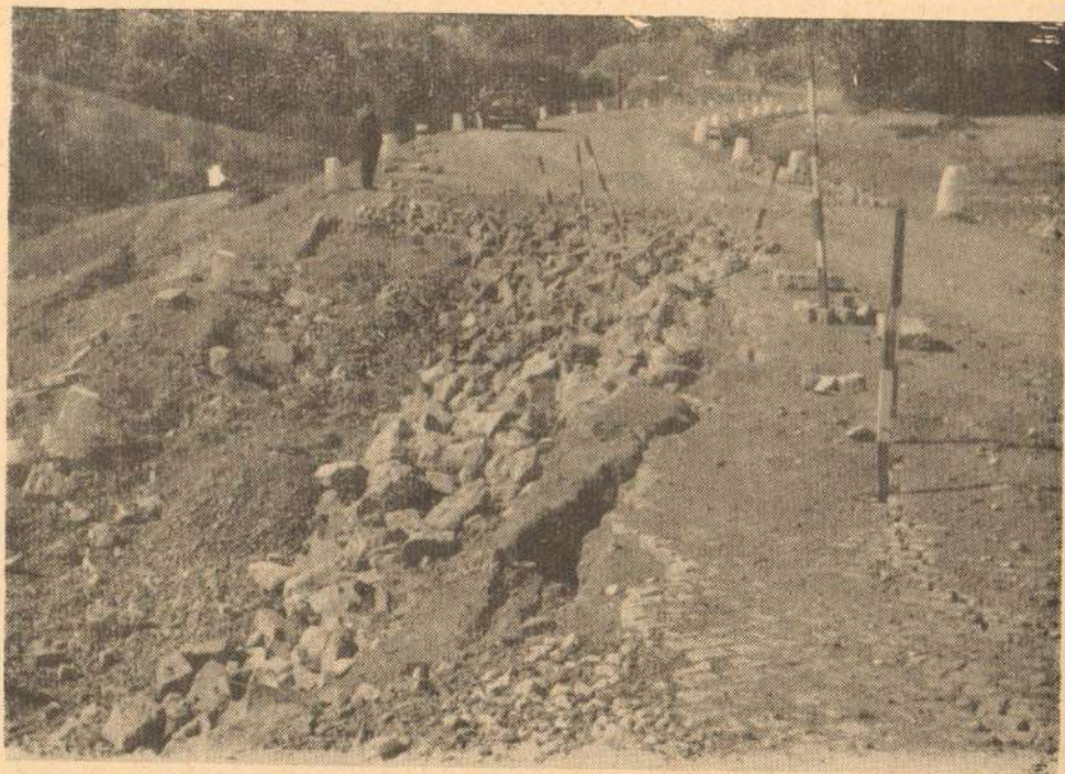
Сл. 5 Поглед на деформисан део пута и насипа на 114. км у атару села Рудник
