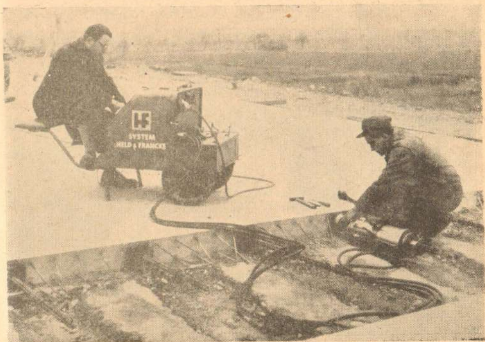
Слика 18 — Затезање подужних каблова.
