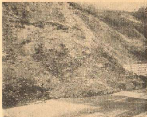
Сл. 12 Одрон у трошним и распаднутим шкриљцима на 118. км
