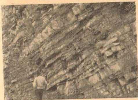
Сл. 1 — Засек у пешчарима, глинцима и лапорцима на 85 км
