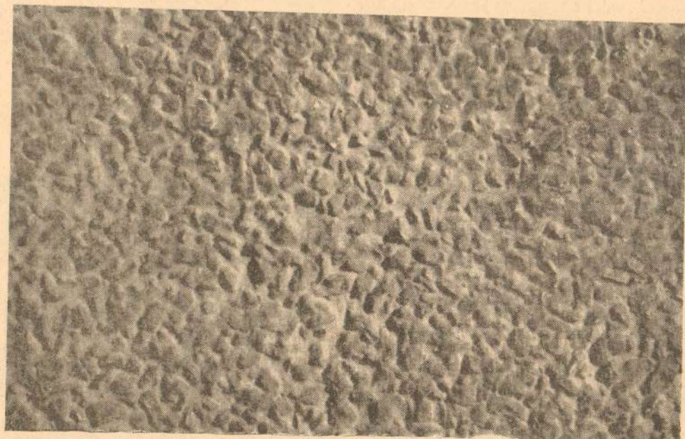
Слика 4 — Структура површине коловоза са асфалтним муљем.
