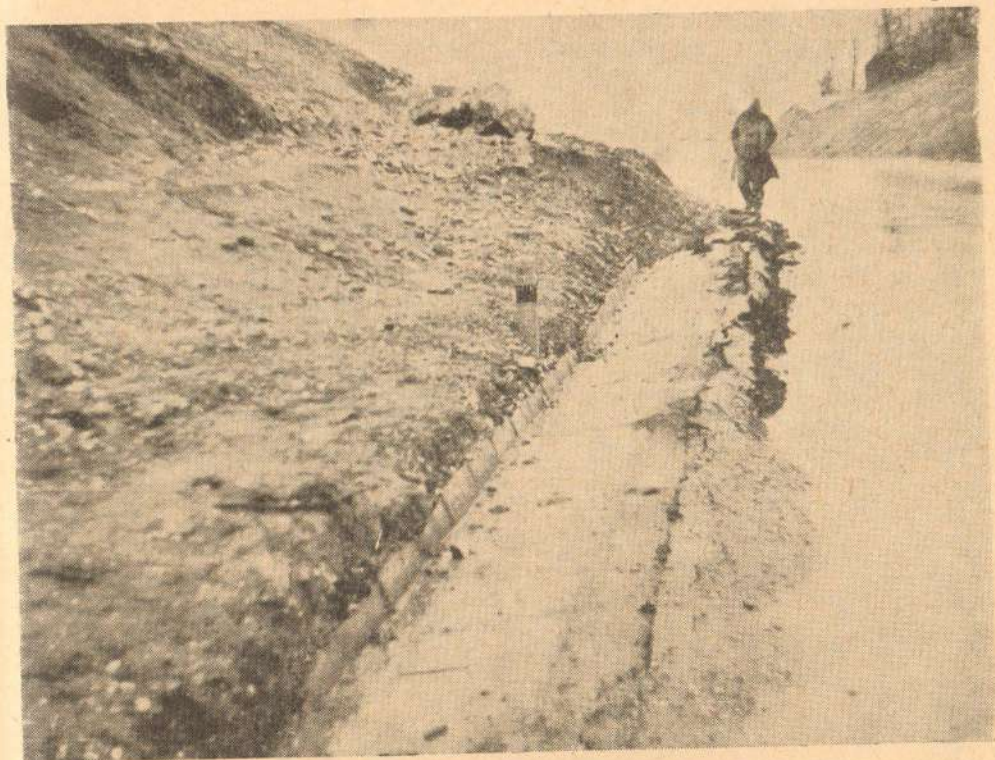
Сл. 6 Клизиште са деформисаним путем на 181. км у усеку на релацији Расна—Ужићи
