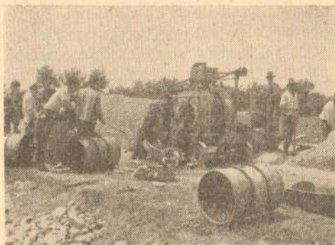
Сл. 15. Мешање каменог материјала са воденим стаклом у бетонској мешалици
