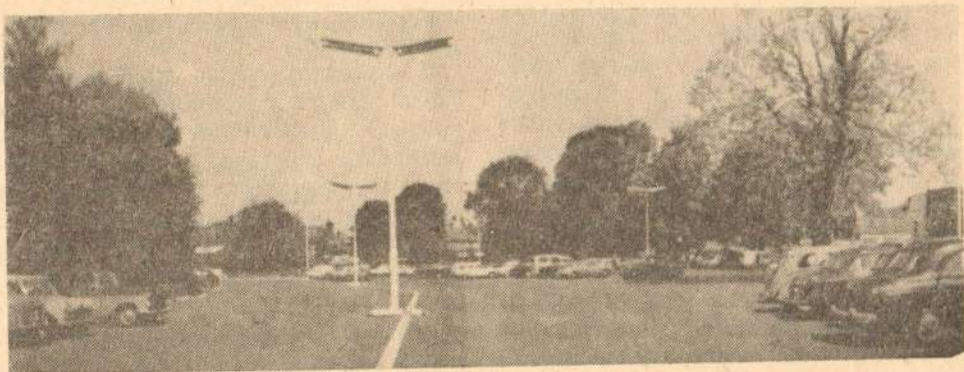
Сл. 1. Простор за паркирање обрађен катранским бетоном
