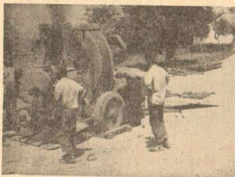
Сл. 12. Обавијање агрегата разређеним битуменом асфалтном машином „Barber Green“
