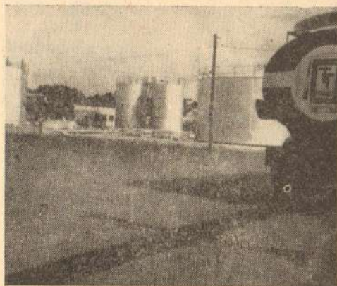
Сл. 4. Бензинско стовариште у Сторпортну — Северна Енглеска. Застор је изграђен од катранског бетона
