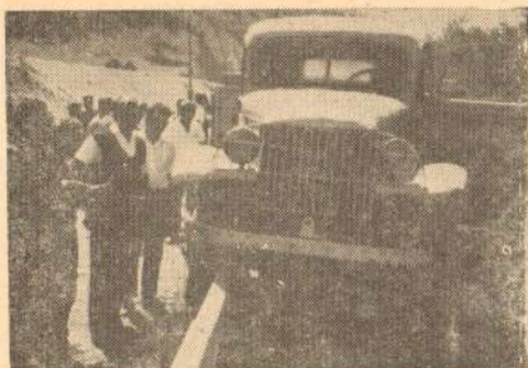
Сл. 15. Теретни ауто „Шевролет“ последи удараца „узјашно“ је ограду (пут удараца 30°, брзина око 45 км/час)
