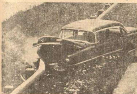
Сл. 9. Ударац аутомобилом у одбојну ограду од челичног олучастог лима и дрвених ступова доста густо постављених. Оштећење возила је било знатно. (Фот. узета из часописа „Popular Science“)
