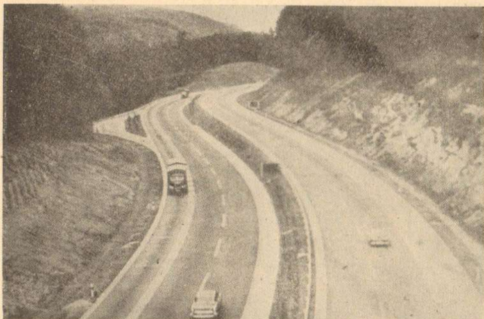
Сл. 2: Јако учљиво оптичко вођење на аутопуту. Спољна трака за вожњу на успону обележена је као саобраћајна трака за тешки саобраћај.
