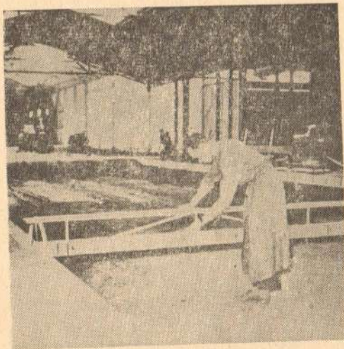
Сл. 10. Покретни уређај за обележавање места на којима ће се вршити испитивање
