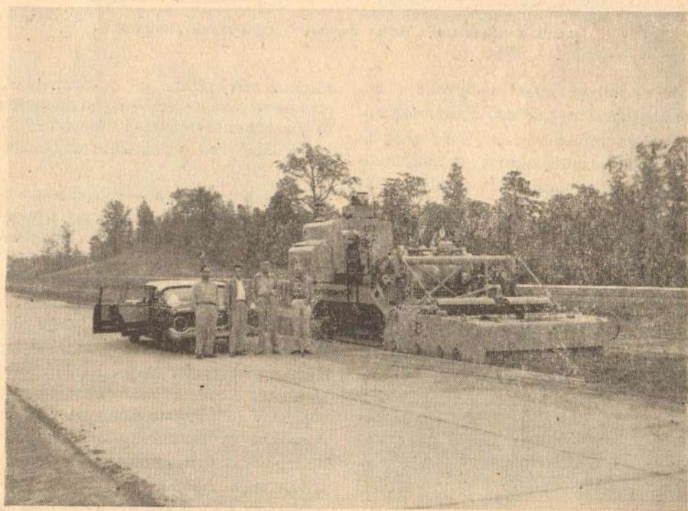
Сл. 15. Стабилизација банкина поред цементно бетонског коловоза
