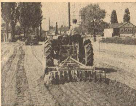
Сл. 8. Стабилизација кречом — рад тањираче на ситљењу
