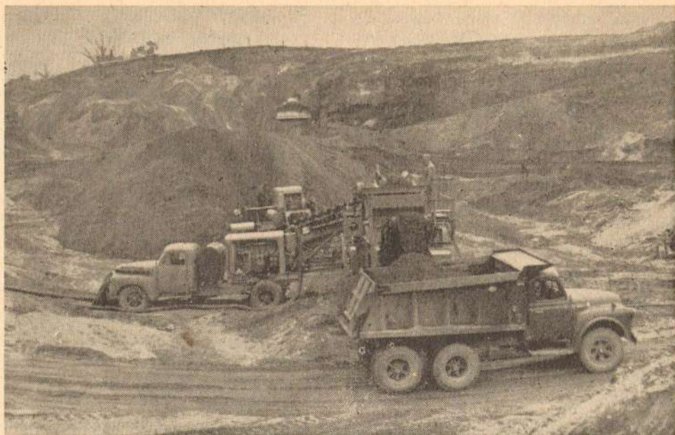
Сл. 5. Производња мех. стабилне мешавине
