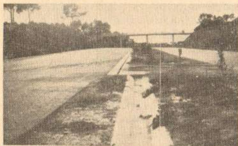
Сл. 17 — Начин одвођења воде са површине коловоза на прелазу из правца у кривину
